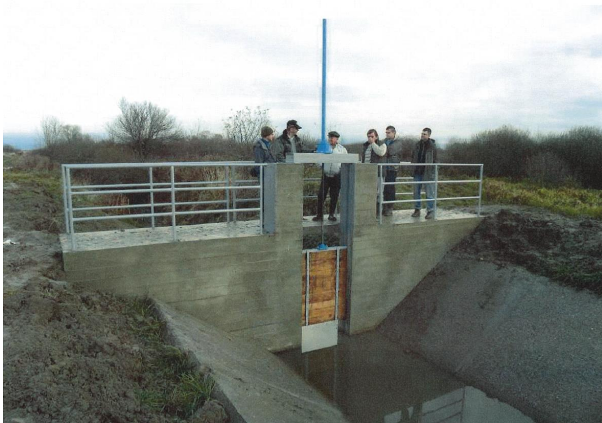
Obr.14 Stavido Iňáčovce - prevzaté zo štúdie Envi Projekt, 2021 (poskytli Hydromeliorácie)
