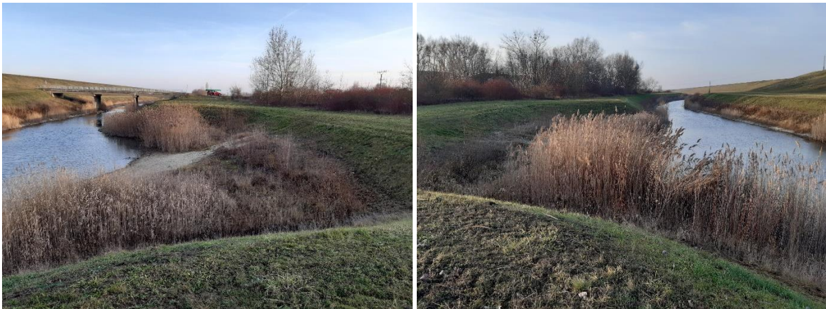
Obr. 7 Príklad miestneho rozšírenia kanála a zmiernenia sklonu brehu
