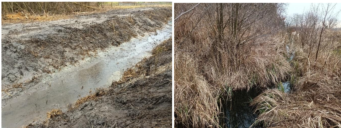
Obr. 30 Vľavo - nevhodná jednoúčelová forma údržby kanála, vpravo - viacúčelová forma kanála umožňujúca súčasné plnenie viacerých funkcií
