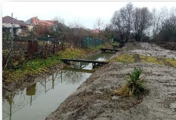
Fotografia č. 5: Stav po čistení zdroj: Hydromeliorácie, štátny podnik
