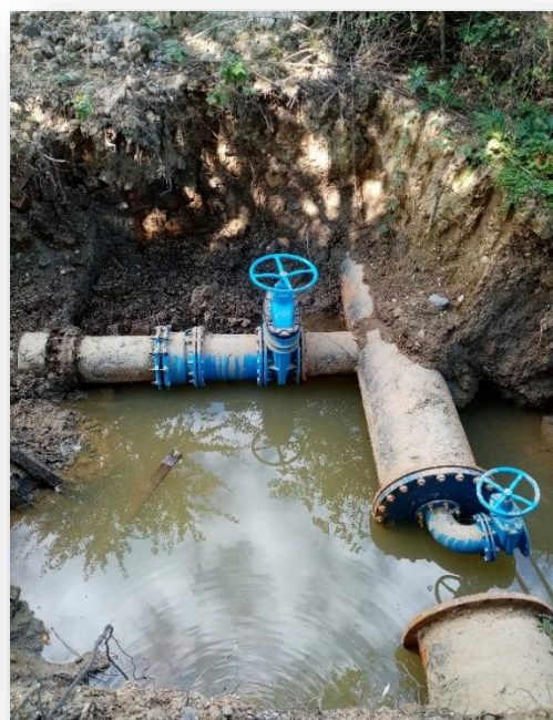
Fotografia č. 11: Výmena uzatváracích armatúr zdroj: Hydromeliorácie, štátny podnik
