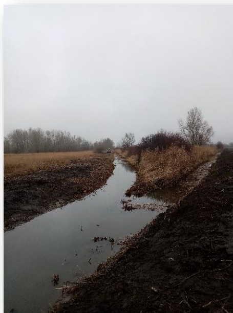
Fotografia č. 6: Stav po čistení zdroj: Hydromeliorácie, štátny podnik
