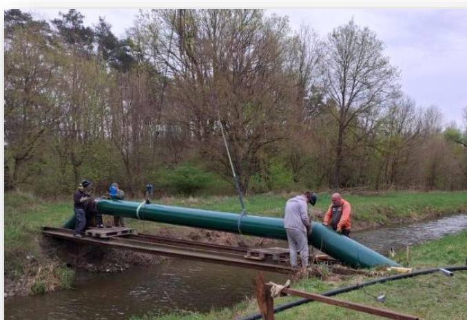
Fotografia č. 7: Oprava výtlačného potrubia zdroj: Hydromeliorácie, štátny podnik
