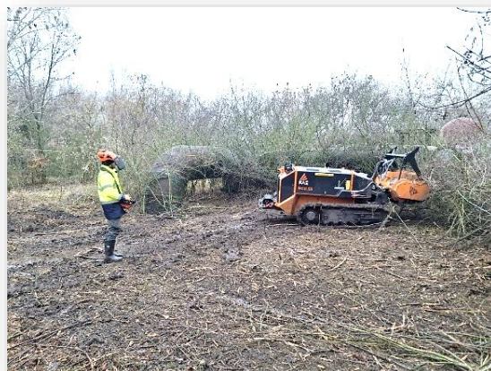
Fotografia č. 3: Čistenie areálu vodnej stavby frézovaním zdroj: Hydromeliorácie, štátny podnik
