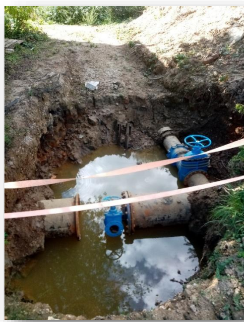
Fotografia č. 12: Výmena uzatváracích armatúr zdroj: Hydromeliorácie, štátny podnik
