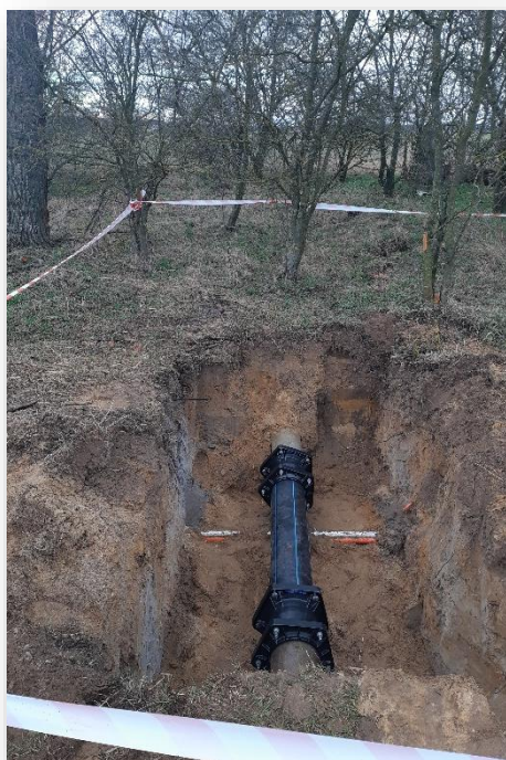
Fotografia č. 7: Oprava výtlačného potrubia zdroj: Hydromeliorácie, štátny podnik
